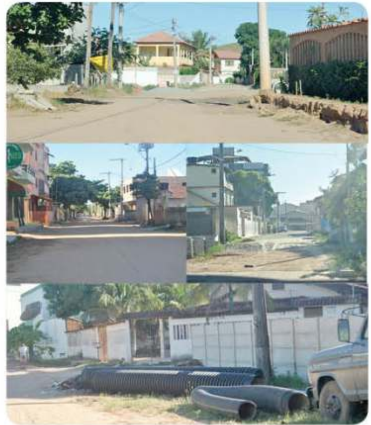
Várilas são as obras da empresa de Gilberto em Piúma
