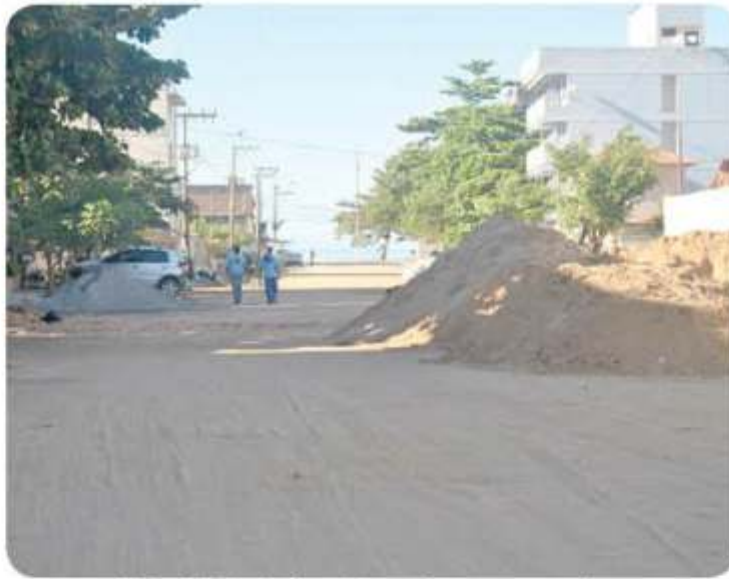
A Rua Terêncio também estava com as obras paradas na segunda-feira
