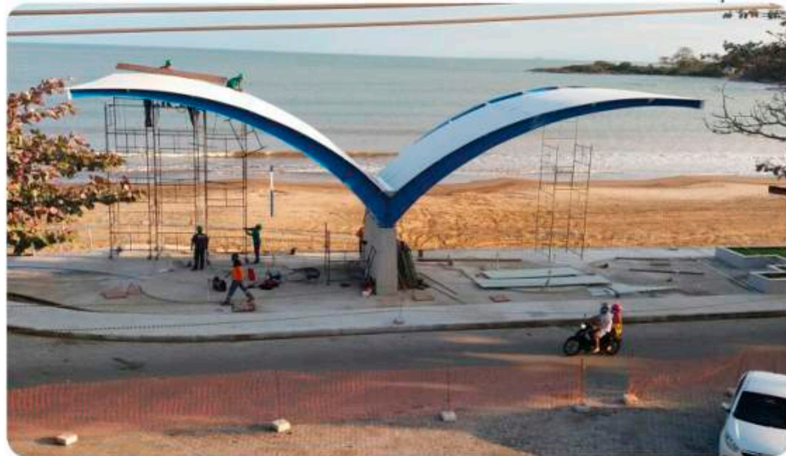
Foram colocadas as asas das garças na obra da Praia Central em Anchieta
